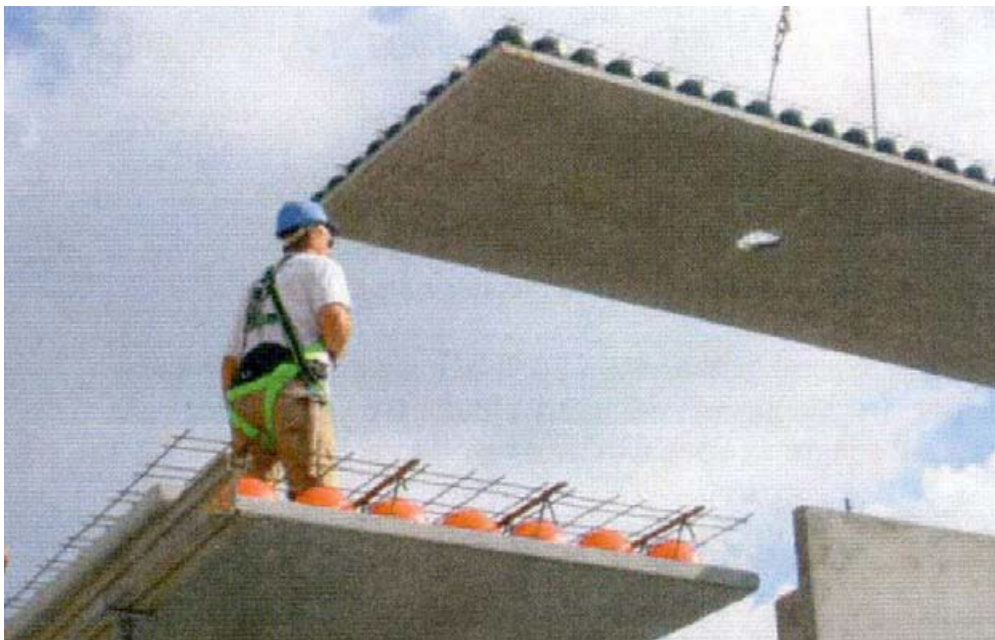
Figur A4 BubbleDeck (BD) er et byggesystem for dekkekonstruksjoner bestående av statisk sett, biaksialt virkende hullplateelementer i betong.
